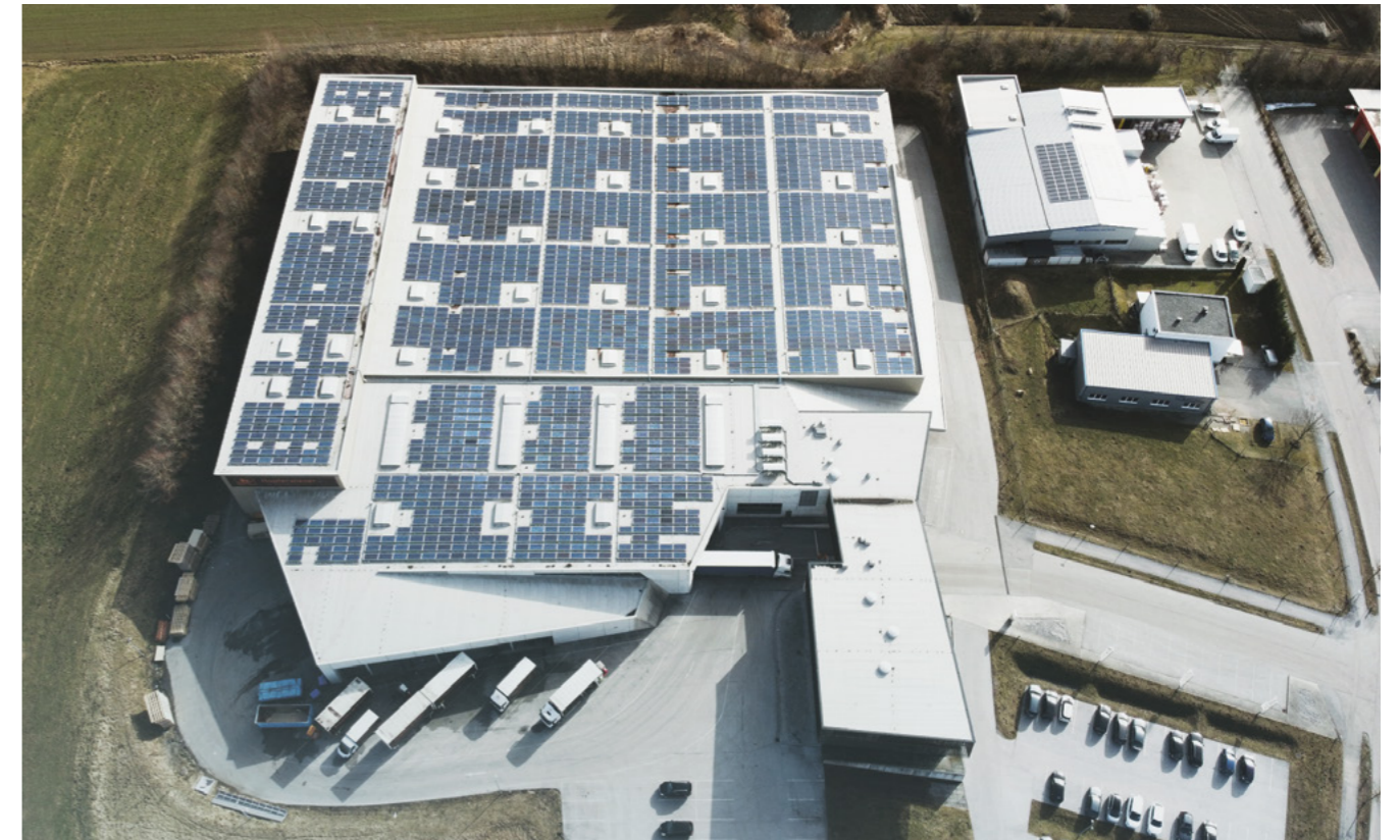
ÖSTERREICH / 546,30 KWP / S10
